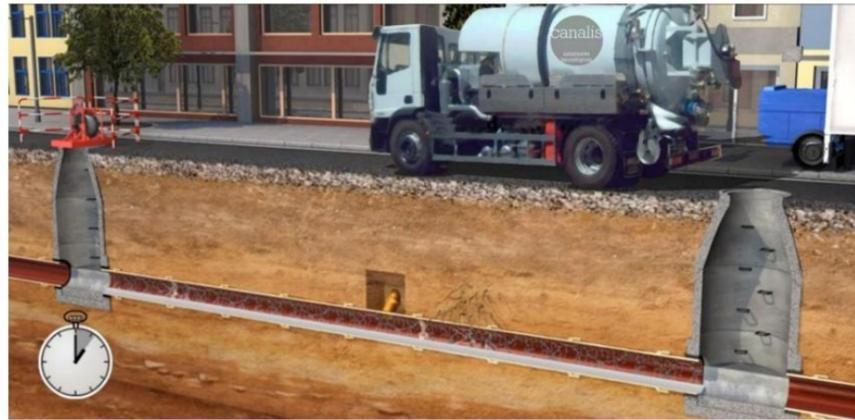
Para garantizar que el colector a rehabilitar se encuentra con las condiciones idóneas para su rehabilitación, se deberá realizar una limpieza del tramo a rehabilitar utilizando sistemas de agua a alta presión y equipos dotados de robot fresador. Si en el tramo a rehabilitar existiesen acometidas, éstas deben localizarse antes de la instalación de la manga mediante estos equipos de fresado.
