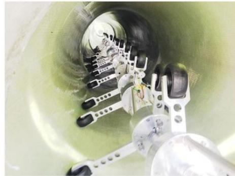
El material utilizado de fibra de vidrio reforzada mediante telas no engarzadas (GRP) preimpregnada con resina de poliéster proporciona a la nueva tubería unas características inmejorables, como una gran resistencia a flexión y un elevado módulo de elasticidad (20.500N/mm<sup>2</sup>), en función del espesor de dicha manga, que puede ir desde los 3mm hasta los 12mm, y del diámetro a rehabilitar, que va de DN150mm a DN1600mm. Asimismo, gracias a la excepcional flexibilidad
