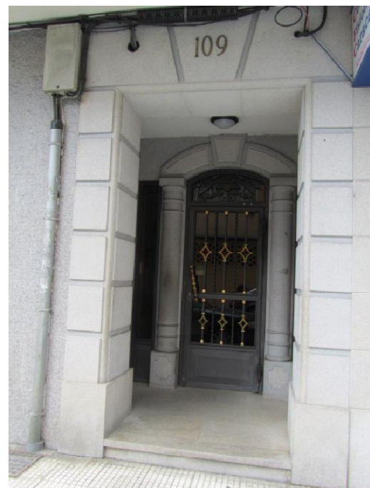
Portal de entrada a edificio nº109
