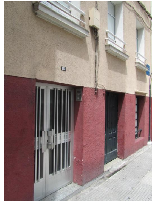
Puerta entrada edificio nº113
