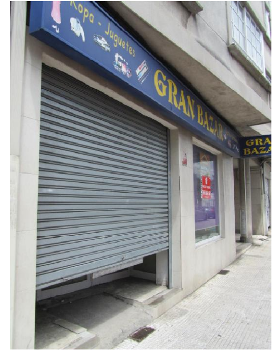
Entrada local Gran Bazar, edificio nº97
