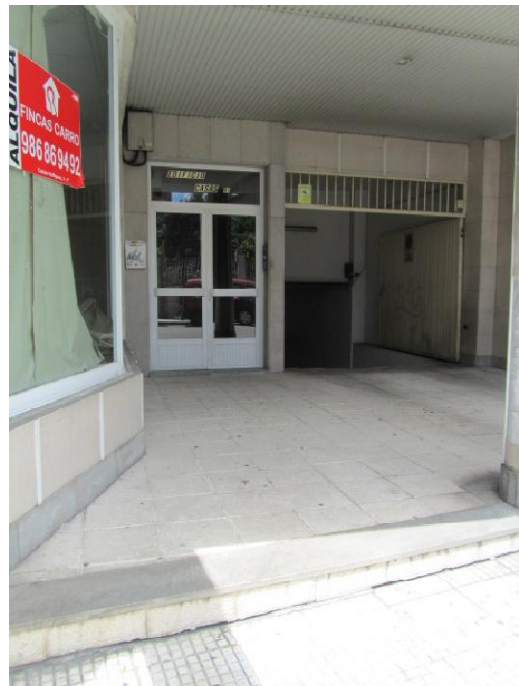
Portal entrada edificio nº97
