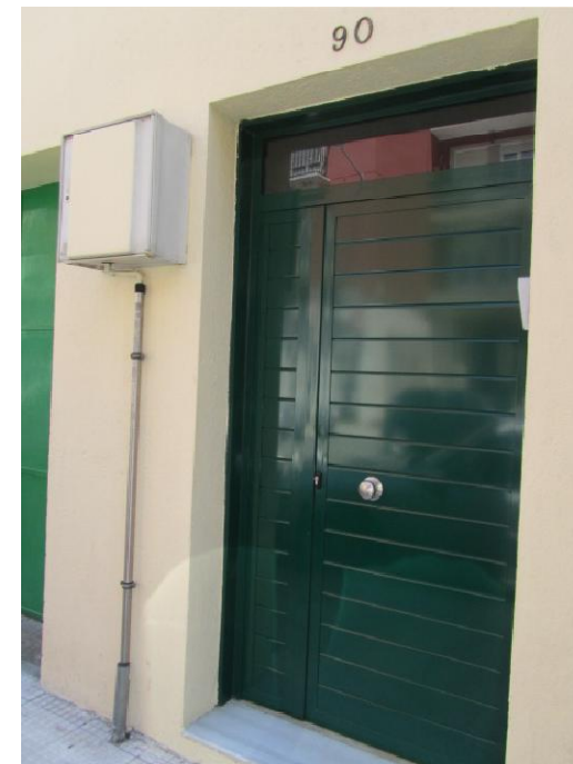
Puerta de entrada del edificio nº 90
