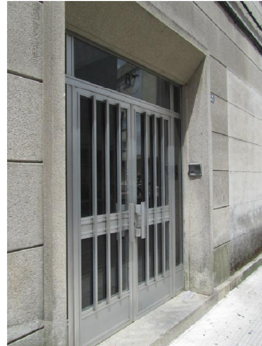
Detalle portal edificio nº 83
