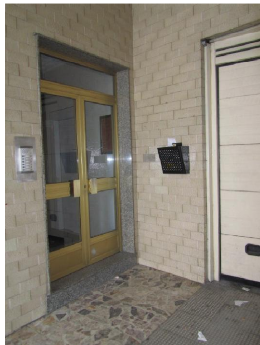
Entrada a portal del edificio nº 68.
