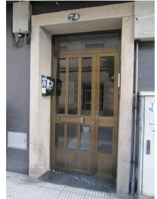
Detalle portal edificio nº 74
