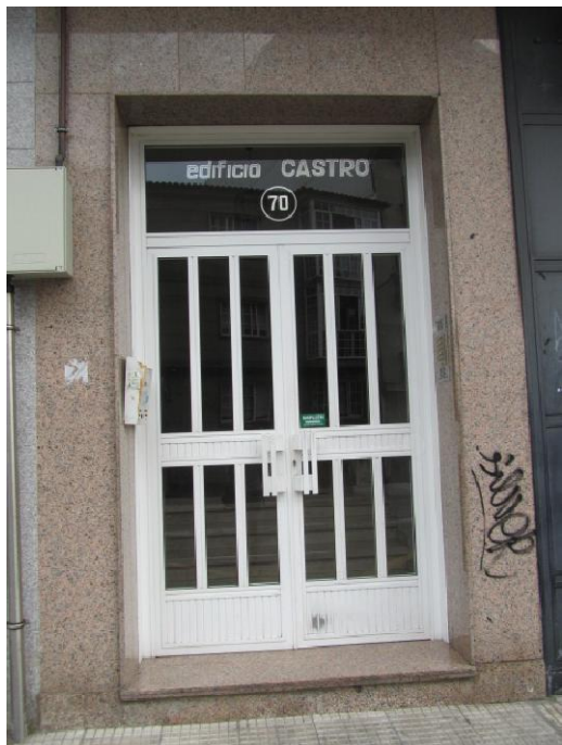
Detalle portal edificio nº 70.
