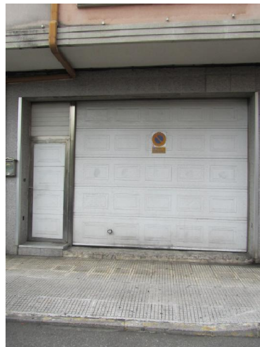
Entrada garaje edificio nº109
