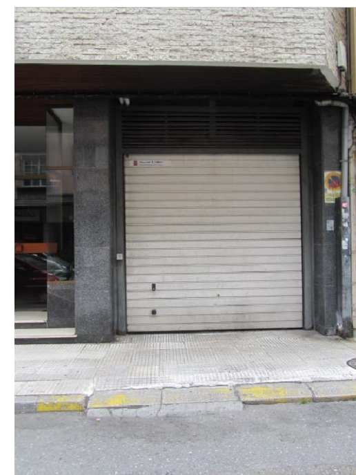
Entrada a garaje del edificio nº 100
