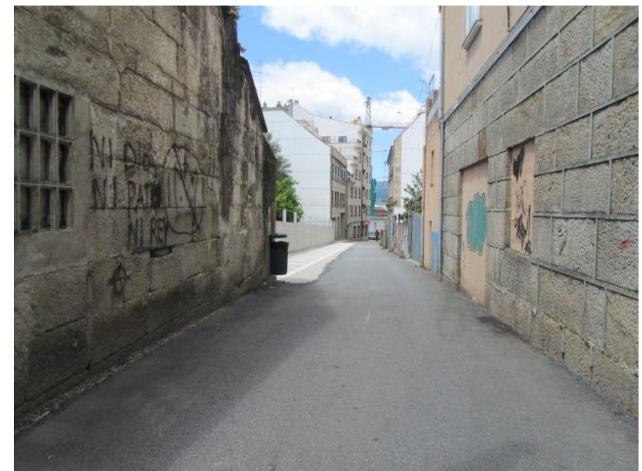
Foto 42, calle do Tombo. A mano izquierda ruina de próxima demolición.
