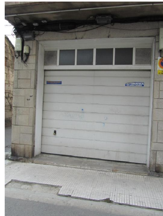
Entrada garaje edificio nº87
