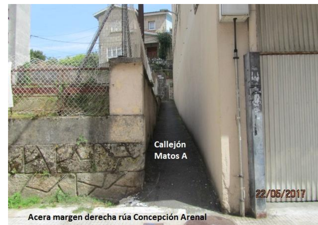
Foto 06, callejón Matos A, que desemboca en la acera de la margen derecha de Concepción Arenal
