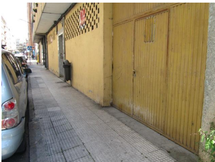
Foto 32, fachada del edificio nº98 de calle Concepción Arenal
