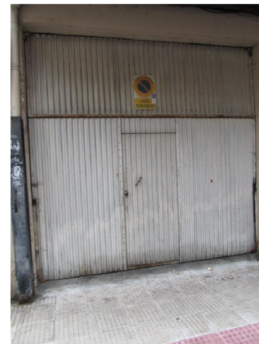
Garaje en bajos del edificio nº100
