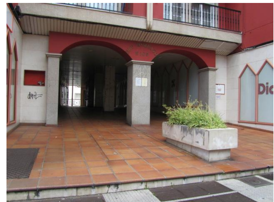
Foto 58, pasillo bajo el edificio Morrazo nº105
