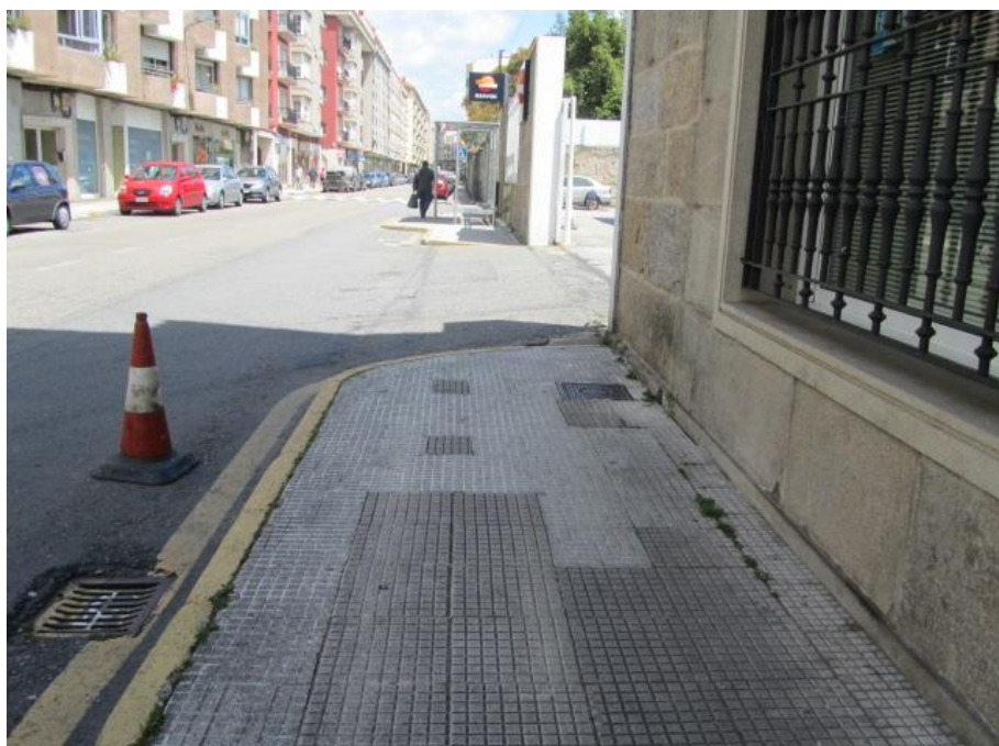
Foto 19, Concepción Arenal llegando a la gasolinera.
