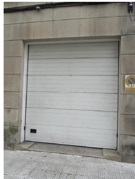
Entrada garaje edificio nº83
