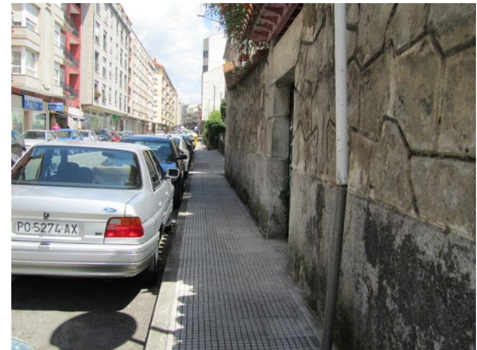
Foto 25, zona de acera estrecha por la alineación del muro de la finca nº86
