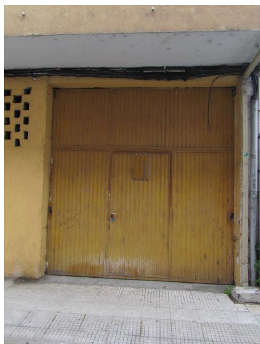
Entrada a garaje del edificio nº 98
