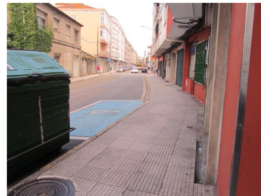
Foto 13, final zona de contenedores. Plaza de aparcamiento reservada para discapacitados delante del nº 72.
