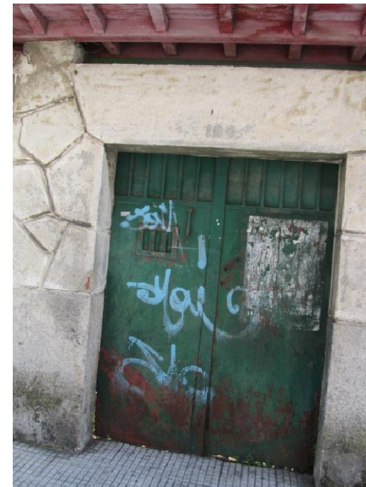
Segunda entrada de la finca nº 86
