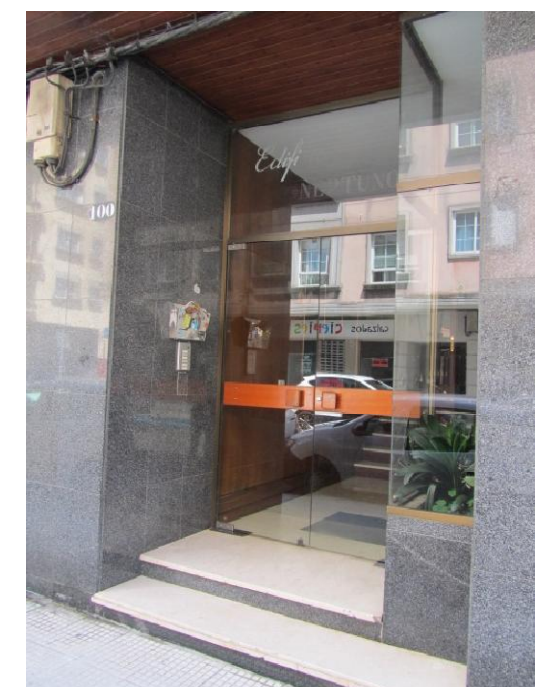
Portal de entrada del edificio nº100
