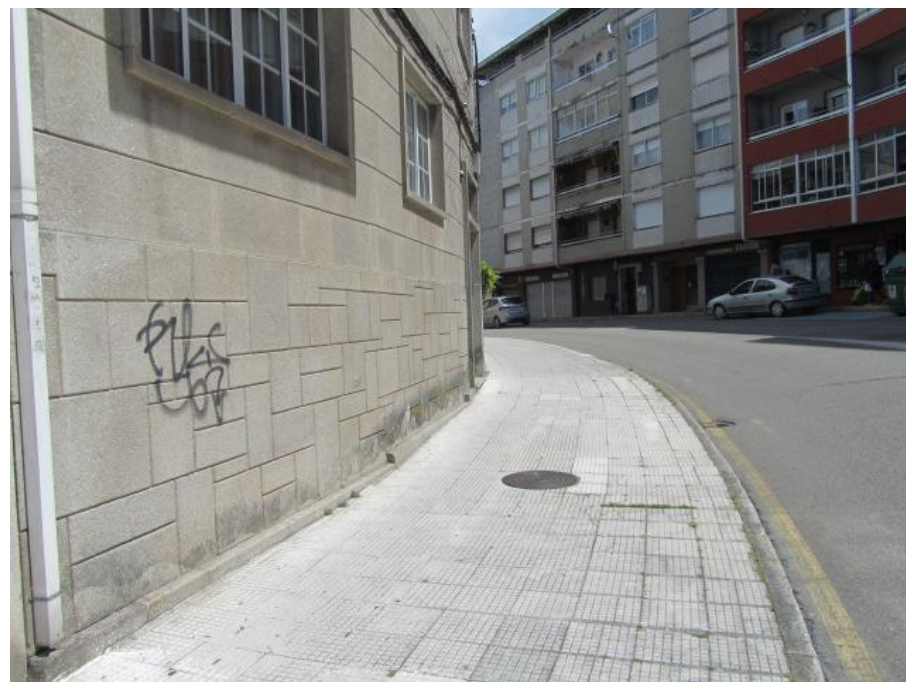
Foto 35, inicio de la actuación en MI, frente a fachada edificio nº 81A
