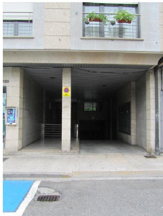
Entrada garaje edificio nº107
