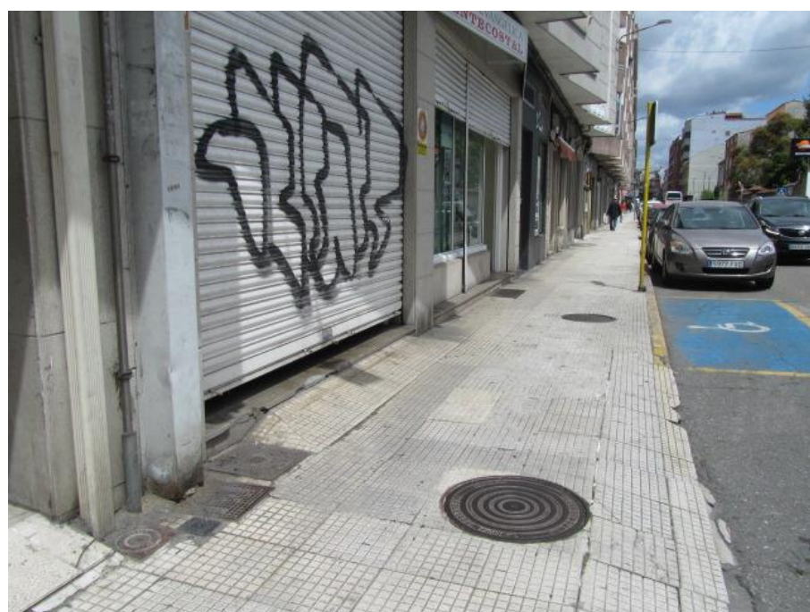
Foto 48, estacionamiento reservado movilidad reducida frente a local Iglesia Evangélica, del edificio nº99.
