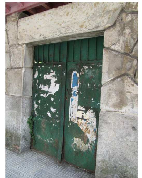
Tercera entrada de la finca nº 86
