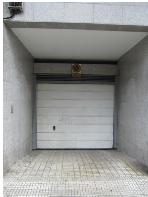
Entrada al garaje del nº 70
